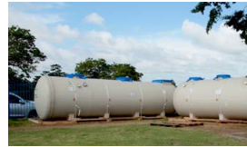
JOHKASOU PARA EL HOSPITAL NICOLÁS SOLANO
