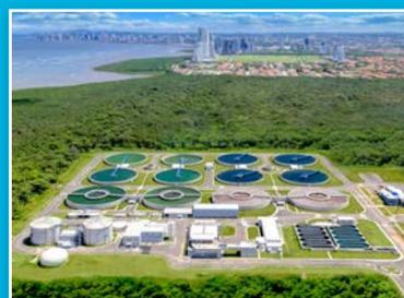
El segundo módulo tendrá la función de ampliar la capacidad de tratamiento de la Planta actual, de  $2.7\text{m}^3/\text{s}$  a  $5.5\text{m}^3/\text{s}$  de aguas residuales que se generen en los distritos de Panamá y San Miguelito.
